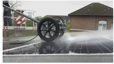
Der Flechtenentferner löst den Bewuchs, geführt von der eigenen Arbeitsbühne aus
