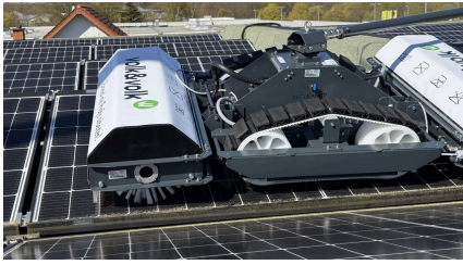
Reinigungsroboter auf der Dachanlage, ferngesteuert von der Arbeitsbühne aus
